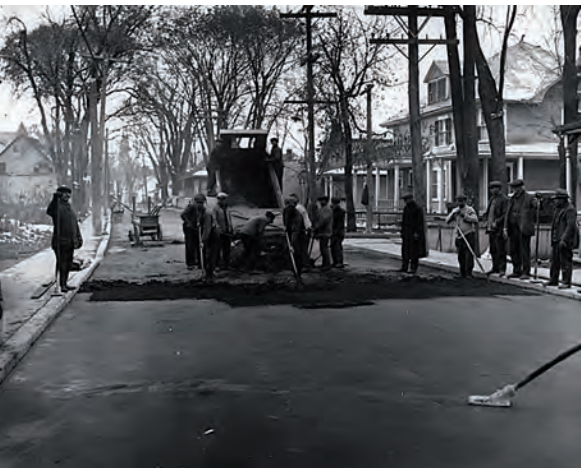
Ouvriers étendant de l'asphalte, Sault-au-Récollet, 1930
