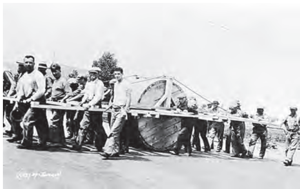
Construction d'une route au camp de travail de Valcartier, 1933
